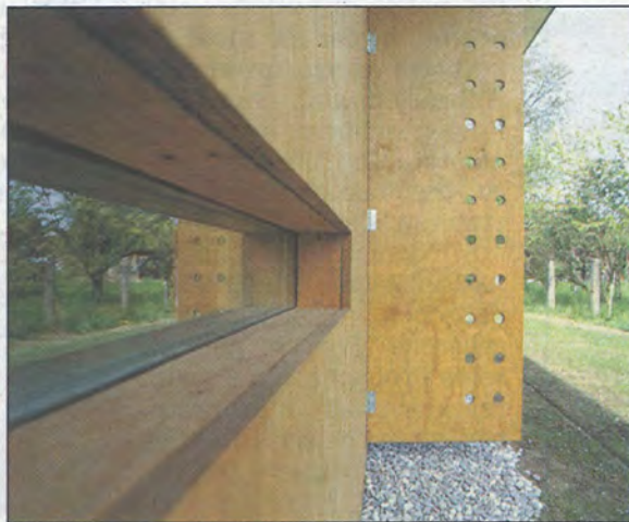
Seekiefer als alternatives Fassadenmaterial für die hintere Breitseite des Hauses.
