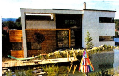
Das „passivHaus+atelier graf“ in Melk ist ein Beispiel für die Umsetzung eines Passivhauskonzeptes im Einklang mit der Natur, dem Umland und der Region. (Fotos (2): Graf)
